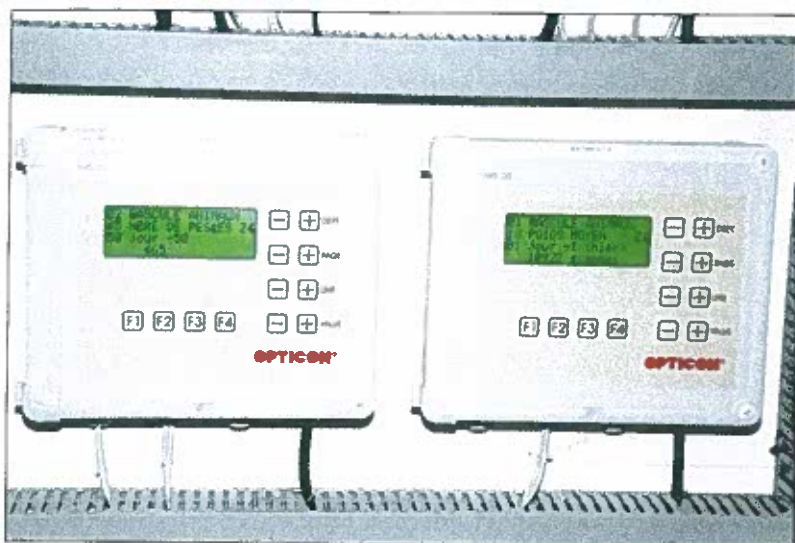
Sur ses boîtiers, Laurent Carré a accès au poids instantané, au poids de la veille, à l'historique de poids sur 51 jours, au taux d'homogénéité du lot. Un seul boîtier permet de gérer quatre plateaux de pesage.
