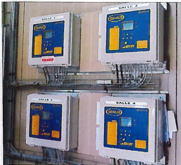
► Chaque salle est gérée indépendamment par le boîtier Genius (Bécot Climatique).
